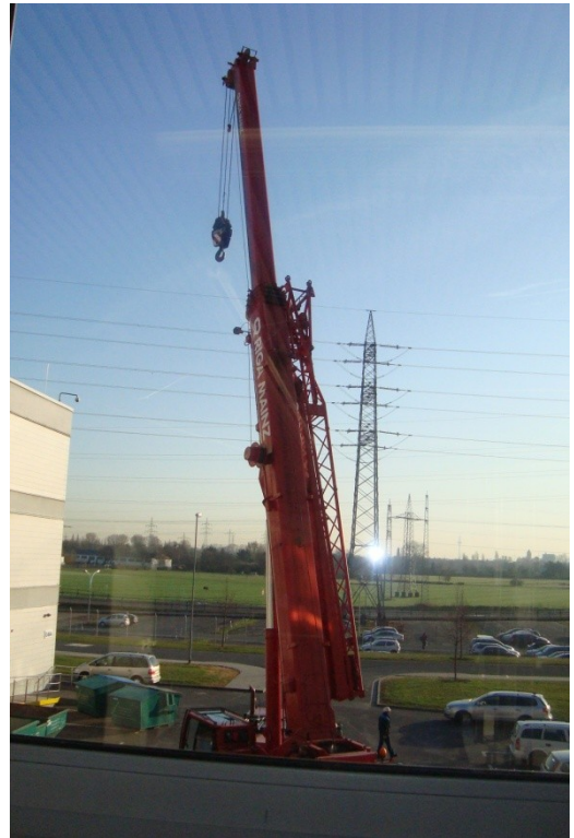
Um die teilweise sehr schweren und sperrigen Geräte auf das Gebäudedach zu hieven, musste auch schon mal der Kran anrücken.
